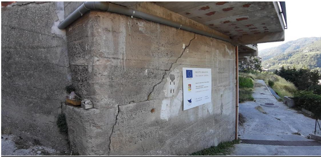
**Figura 13 – Particolare lesione laterale**
